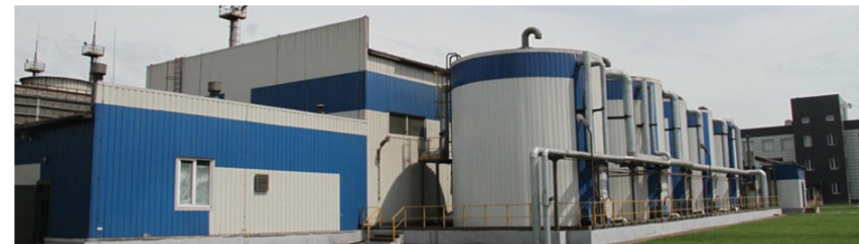
■ Газотурбинна електростанція, Луганська обл., м. Алчевськ
